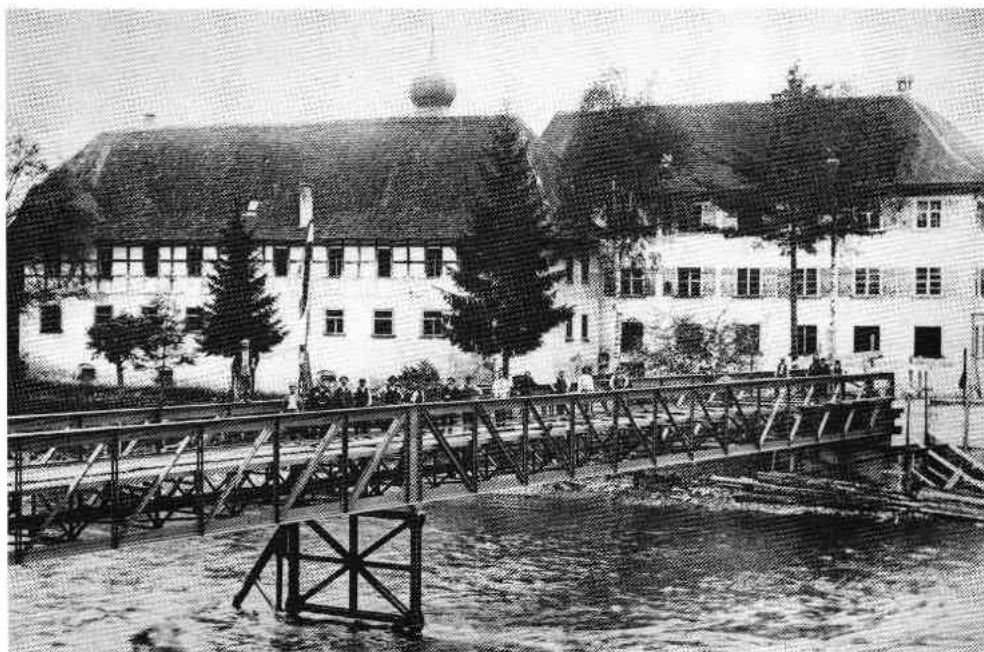
Brückenneubau im Gnadenthal 1909.
