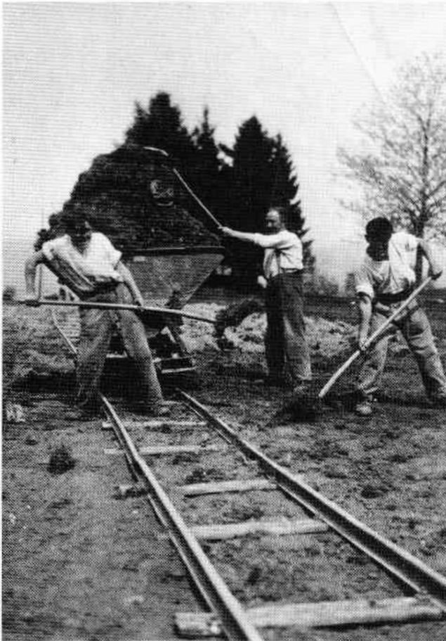
Arbeiter beim Bau der neuen Wohlerstrasse 1931.
