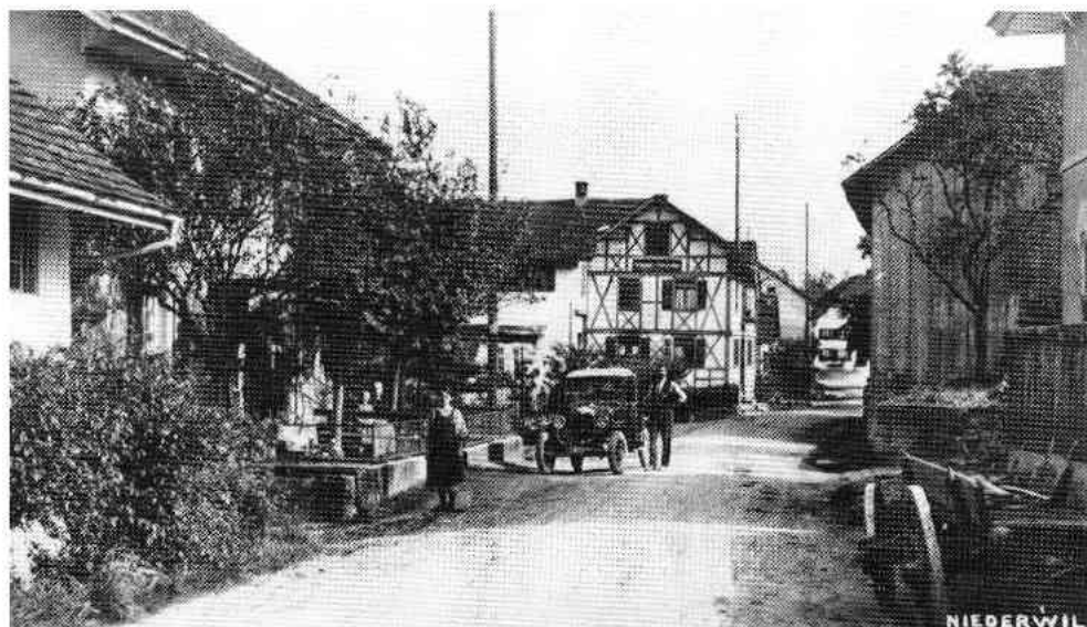
Übergang: erste Autos, Mistwagen, Freileitungen und Naturstrassen ohne Kanalisation.
