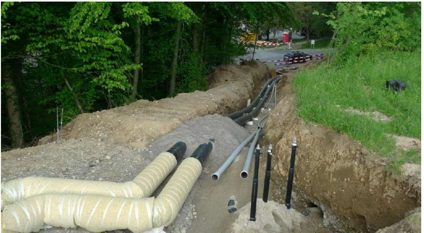
(Schlussstück 1. Etappe Ringschluss inkl. Fernwärmeleitung)
