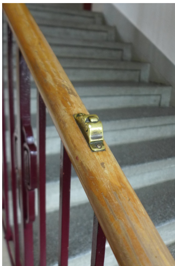
Abbildung 14 Ehem. Schulhaus, heute Gemeindehaus Niederwil. – Das schmiedeeiserne Treppengeländer im Innern zeigt bauzeitliche Details wie die stilisierten Voluten und die schmucken Messinghocker – eine baulich-erzieherische Massnahme gegen das Geländerrutschen der Schulkinder. (Foto 28.6.2022, Kantonale Denkmalpflege)
