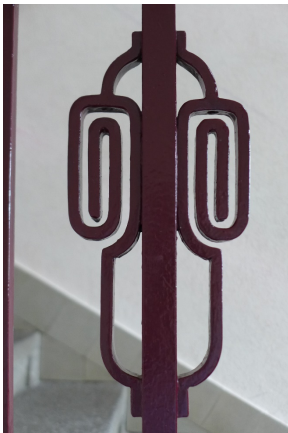
Abbildung 14 Ehem. Schulhaus, heute Gemeindehaus Niederwil. – Das schmiedeeiserne Treppengeländer im Innern zeigt bauzeitliche Details wie die stilisierten Voluten und die schmucken Messinghocker – eine baulich-erzieherische Massnahme gegen das Geländerrutschen der Schulkinder. (Foto 28.6.2022, Kantonale Denkmalpflege)
