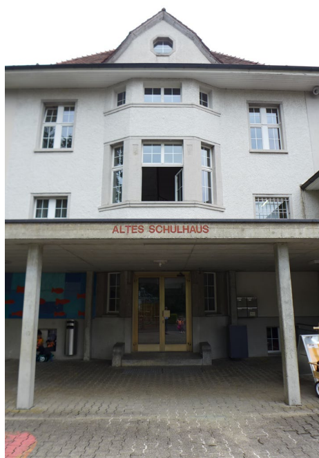
Abbildung 11 Ehem. Schulhaus, heute Gemeindehaus Niederwil. Ansicht von Westen. – Der Eingriff aus den 1970er-Jahren unterbricht die vertikale Ausrichtung des erkerartigen Treppenhauses aus der Bauzeit. (Foto 28.6.2022, Kantonale Denkmalpflege)
