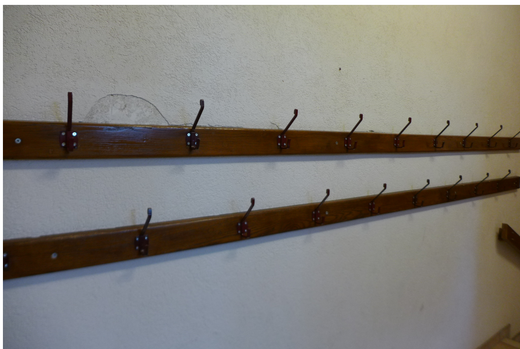
Abbildung 16 Ehem. Schulhaus, heute Gemeindehaus Niederwil. – Die vermutlich bauzeitlichen Garderobehaken im Untergeschoss zeugen von der einstigen Nutzung des Saals als Turnhalle. (Foto 28.6.2022, Kantonale Denkmalpflege)
