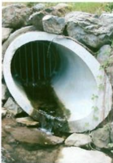
Feststoffe am Gitter sauberes Wasser
